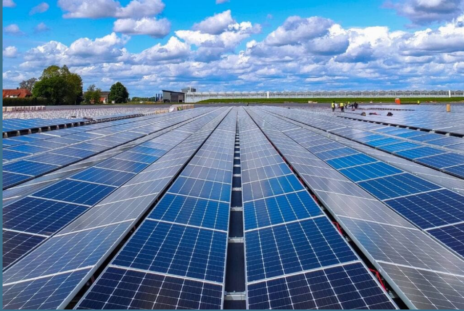
ภาพที่ 5 การติดตั้งแผงโซลาร์เซลล์บนผิวน้ำ (Floating Solar) ที่มา : https://www.scg.com/innovation/floating-solar-farm
