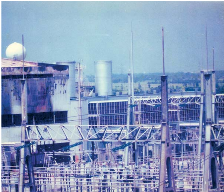
สภาพโรงไฟฟ้าพลังเกิดเพลิงไหม้
